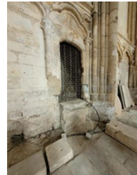
Figure 16 : porte qui mène au clocher
