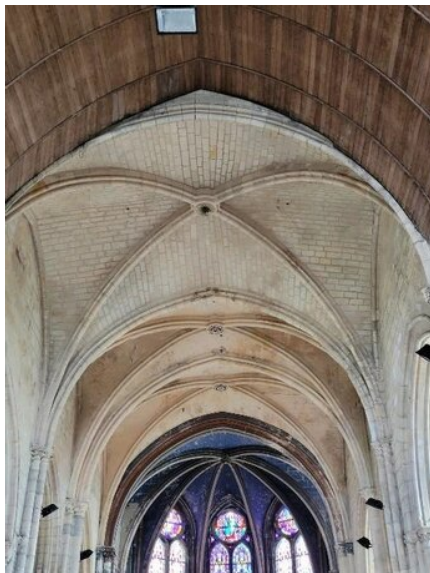
Figure 8 : plafond avec zone de transition
