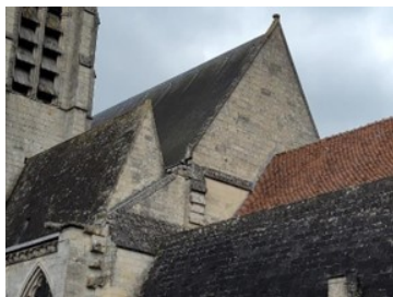
Figure 1 : Des toits à différentes hauteurs, des harpes de pierre et un pignon « d'attente »
